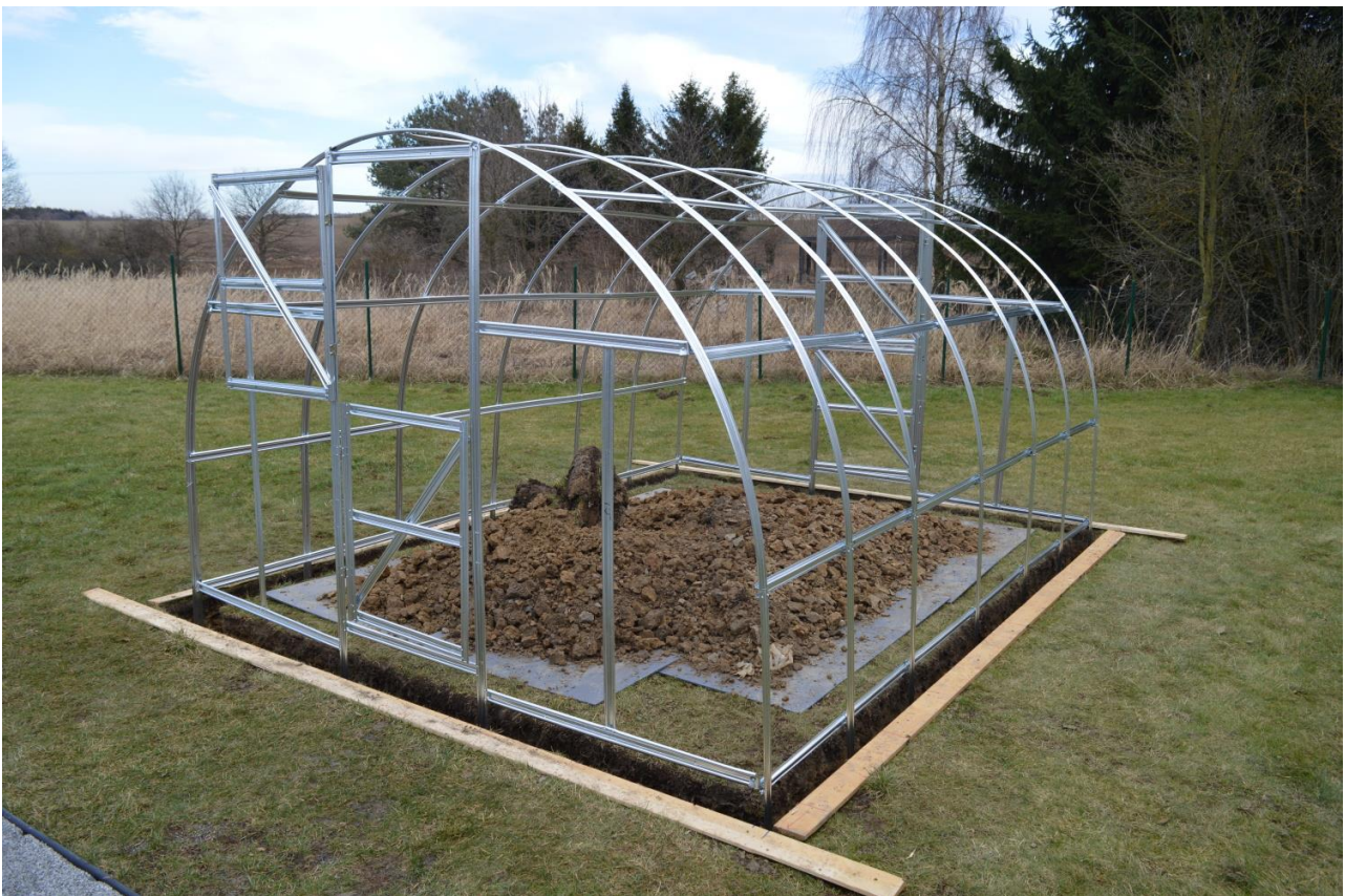
Ilustračný obrázok ukotvenia konštrukcie skleníka Kyklop (modelový rok 2017) do krajiny (Jednotlivé profily sa môžu svojou polohou odlišovať v závislosti od modelu, rozmeru a na roku výroby skleníka) princíp ukotvenie do zeme je zhodný u všetkých modelov rady Kyklop
