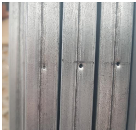
Pripravené otvory na skrutky
