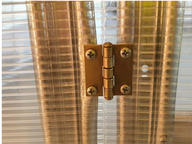
az üvegház és a polikarbonát lemez külső felére szerelt pánt részlete
