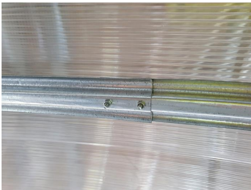
pohled z vnitřní strany skleníku na detail 1
