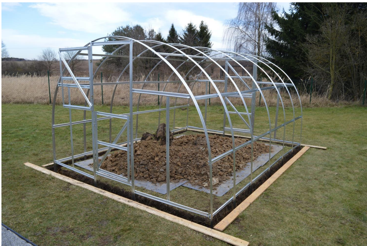
Ilustrativní obrázek ukotvení konstrukce skleníku KYKLOP 3x4 (modelový rok 2017) do země (jednotlivé profily se mohou svou polohou odlišovat v závislosti na modelu, rozměru a na roku výroby skleníku)
